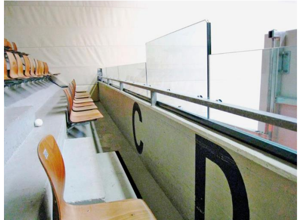
Abbildung 48 Absturzicherung aus Verbund-Sicherheitsglas – im Bereich der Treppe erhöht
