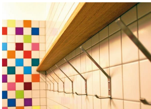
Abbildung 35 Nachträglich montierte Schutzleiste
