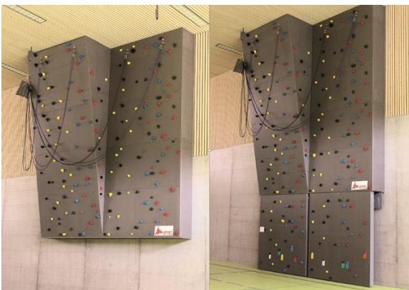
Abbildung 19 Hinaufschiebbarer Kletterwand mit Elektromotorantrieb
