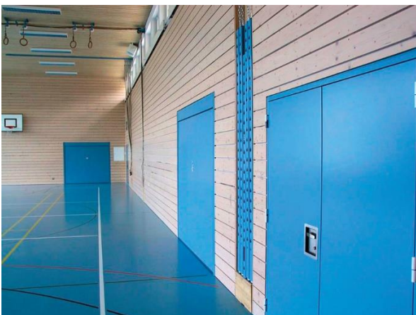
Abbildung 10 Das Prinzip der glatten Wand ist eingehalten.
