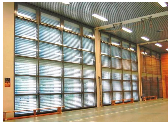
Abbildung 27 Beispiel einer «geschlossenen» Fensterfront
