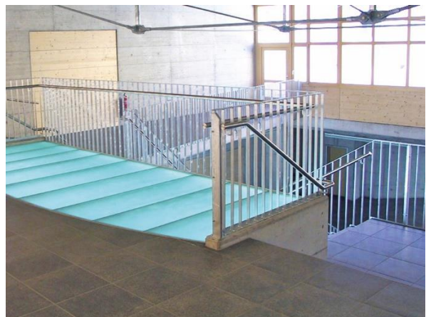
Abbildung 39 Normgerechte Geländer und Handläufe
