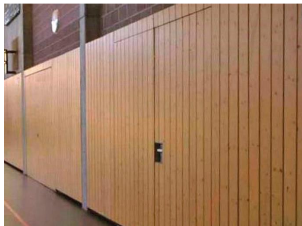
Abbildung 11 Fugenbreite max. 8 mm
