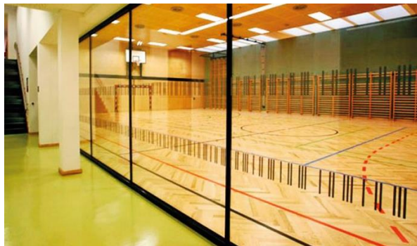
Abbildung 24 Einscheiben-Sicherheitsglas mit Kontraststreifen verhindert Verletzungen
