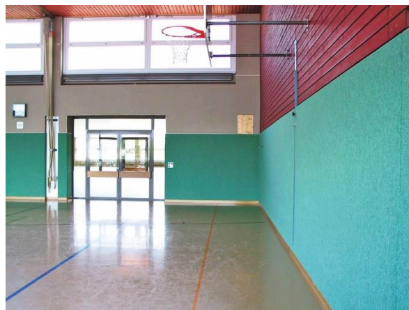
Abbildung 13 Sporthalle mit Prallschutz an den Wänden
