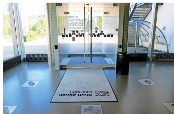
Abbildung 2 Schmutzschleuse im Eingangsbereich einer Sporthalle
