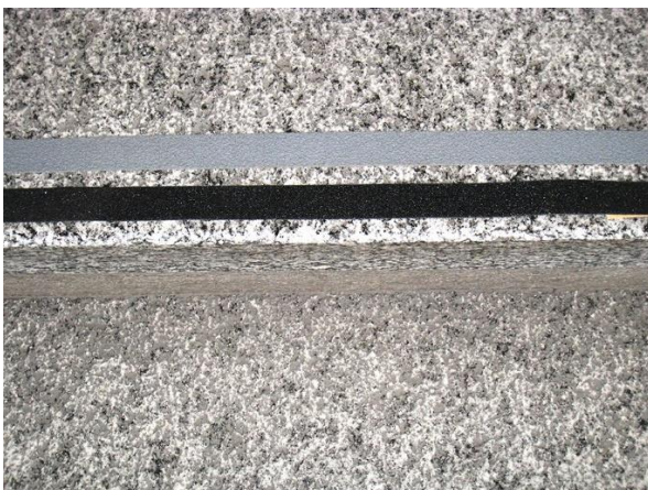
Abbildung 38 Treppentritt mit Gleitschutzstreifen in Kontrastfarbe
